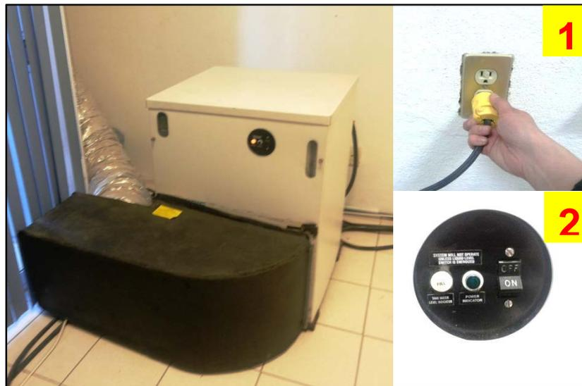
Figura 11. Baño recirculador Haskris, procedimiento de encendido: (1) conectar a la luz, (2) encender switch modo ON.
